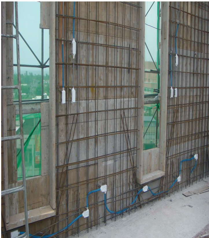
◎ .6F 頂版灌漿、7F 柱. 鋼筋綁紮，柱內配管、牆內配管
