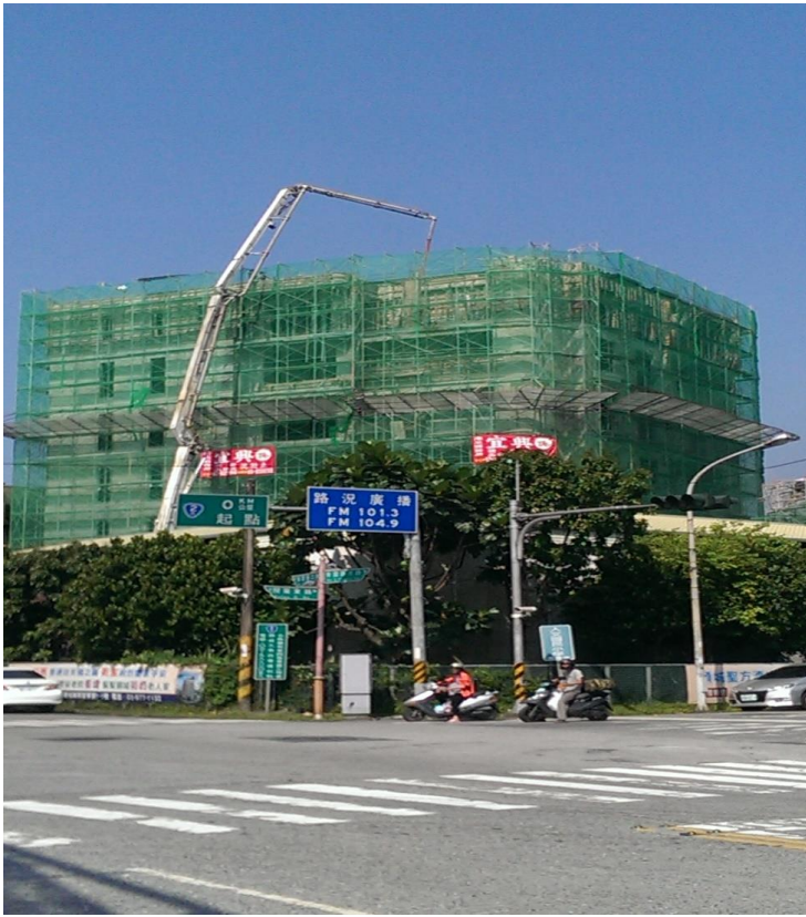
◎7F 頂版灌漿、8F 牆、柱內配管頂版灌漿、上樑祈福
