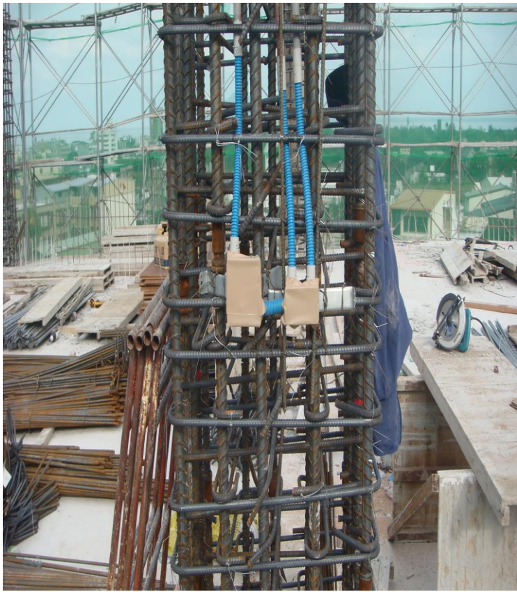
◎ .6F 頂版灌漿、7F 柱. 鋼筋綁紮，柱內配管、牆內配管
